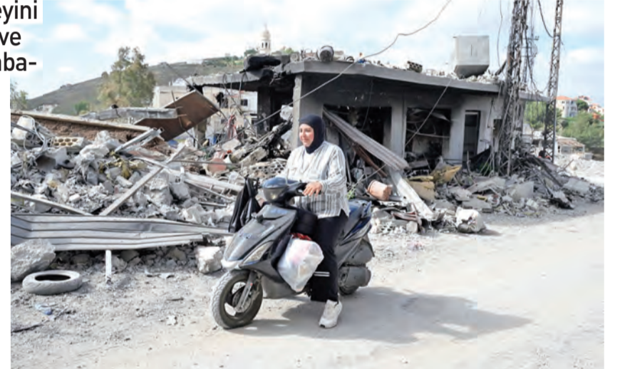
ABD ile İran arasında sağlanan mutabakatın ardından Lübnan'ın güneyindeki Nebatiye iline bağlı Furun beldesindeki evlerine dönen Lübnanlılar, yıkılmış ve hasar görmüş binalarla karşılaştı. AA
